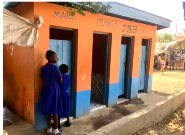
Het gerenoveerde toiletgebouw
