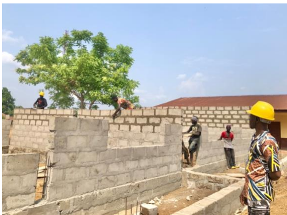
Drie klaslokalen in aanbouw
